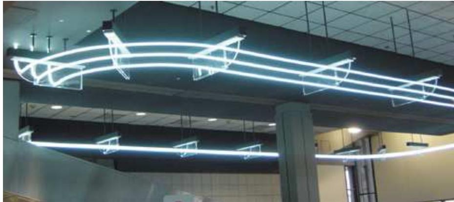
**Abb. 3.4 :** Tageslichtbeleuchtung mit Seitenlichtfasern [20]
