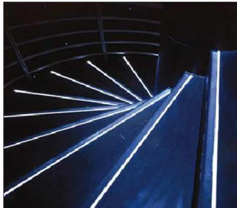
Abb. 3.1 : Stufenmarkierungen mit Seitenlichtfasern [16]
