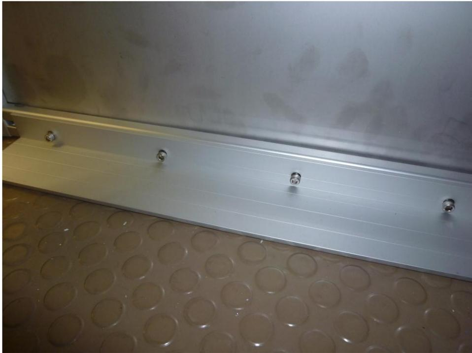
Figure 22 - Fixation pour ancrage de l'observatoire
