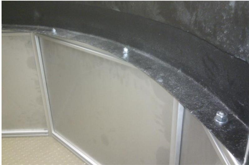
Figure 11 - Fixation du dôme à la base Items
