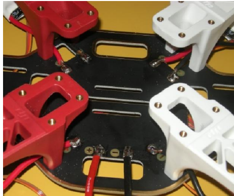
Figure 20 - Les câbles d'alimentations sont soudés sur la "PowerBoard"
